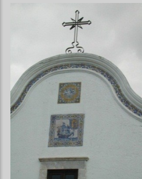
Pormenor da fachada
